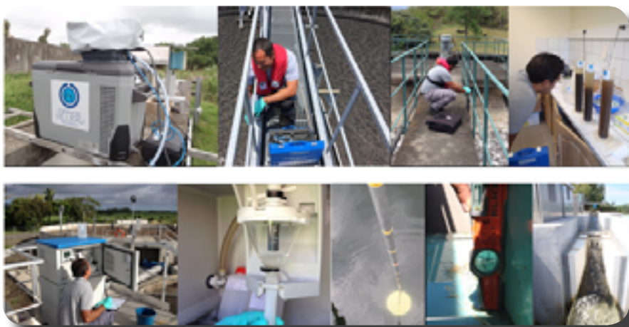
Interventions d'assistance technique sur des stations d'épuration des eaux usées
